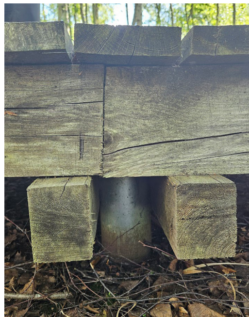
Boardwalk i Bøllemosen / Jægersborg Hegn. Etableret med skruefundament
